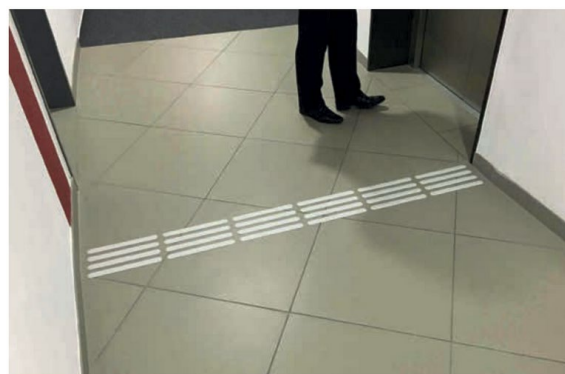
Abb. 4: links: Orientierungsboje als taktile Metallfliese; rechts: Auffindestreifen in einem Flur zum Auffinden eines Türschildes beide Quelle: Metlitzky, Engelhard (2024)
